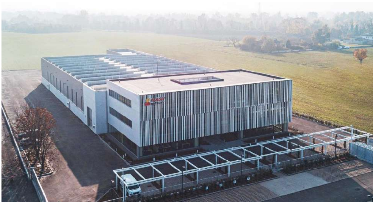
Il nuovo stabilimento Flash Battery a Sant'Ilario d'Enza
