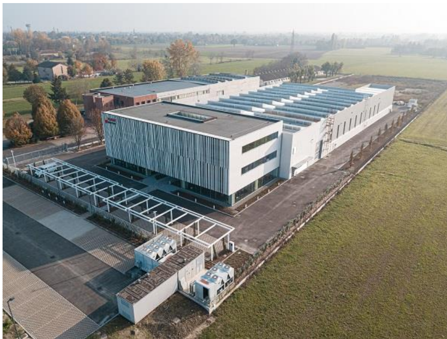
Una vista aerea della nuova sede
