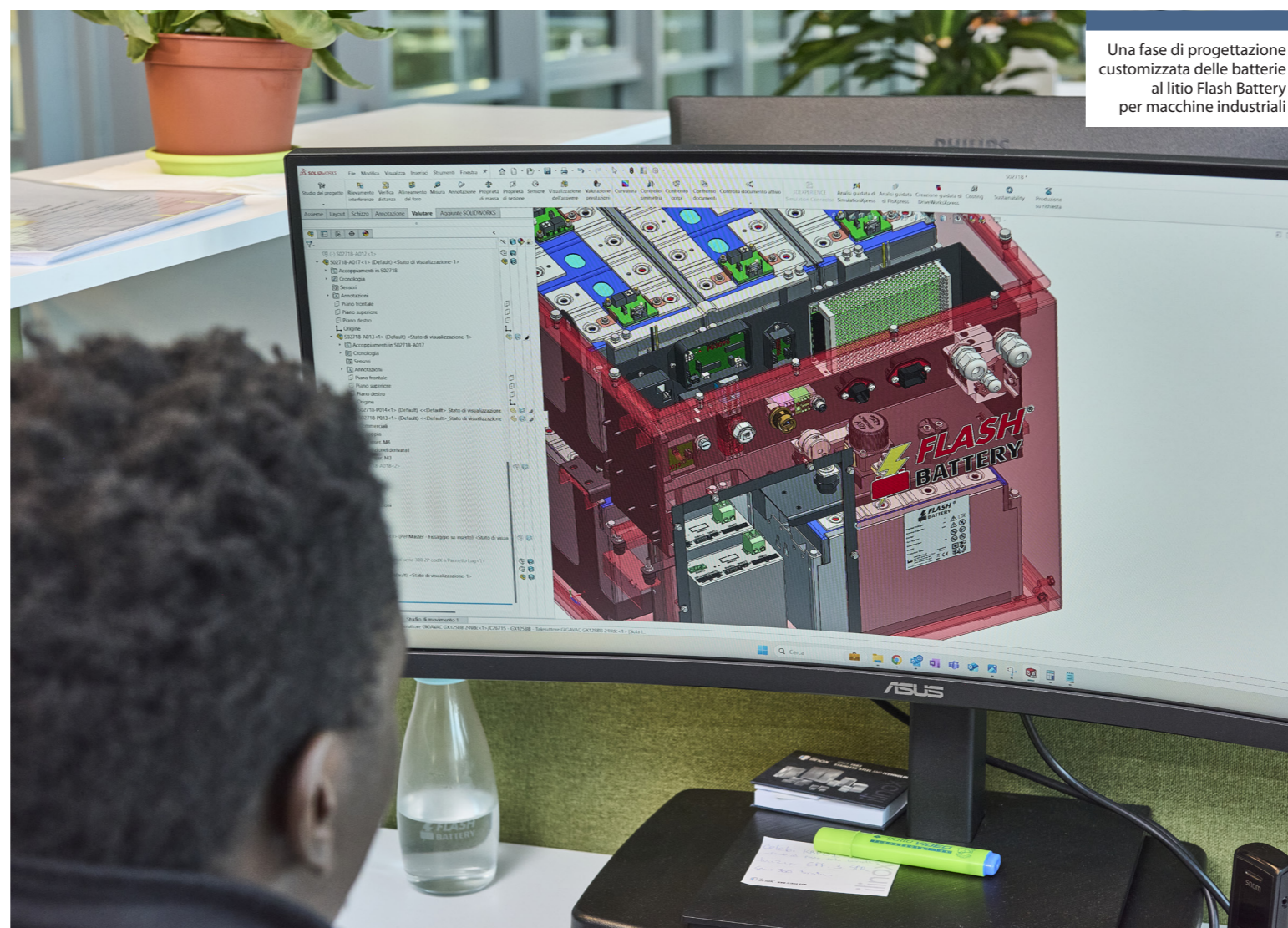
Liinterfaccia del Flash Data Center, tecnologia proprietaria per il controllo remoto evoluto e la diagnostica predittiva di Flash Battery
